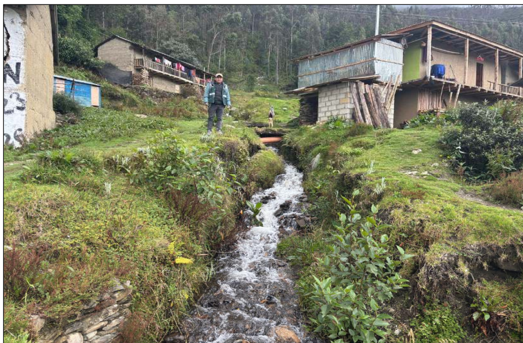
Figura N° 01. Las viviendas cercanas a la quebrada Chequias están en riesgo de erosión y debilitamiento estructural si el cauce crece. La corriente ya ha afectado las orillas, lo que podría provocar deslizamientos y daños a los accesos
